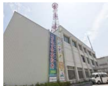
中海テレビ放送センタービル
